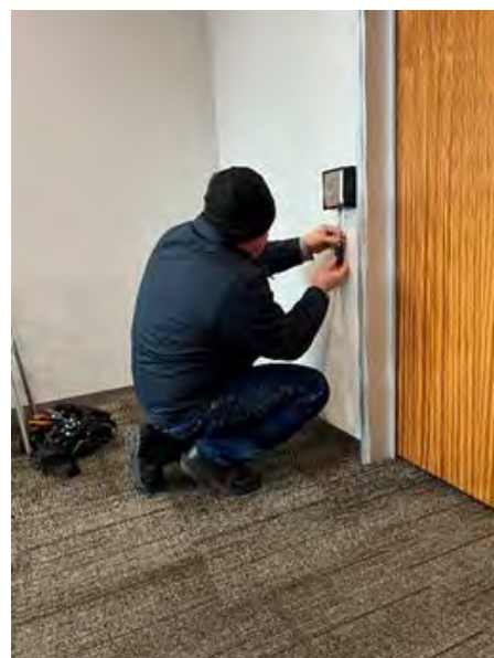
ADA Door Opener Switch Repair
